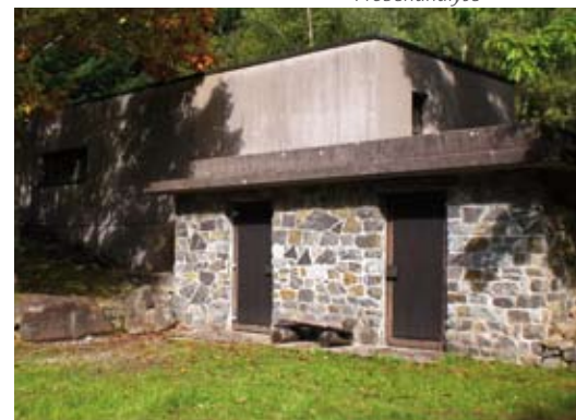
Hochbehälter Hofberg in Hausach
